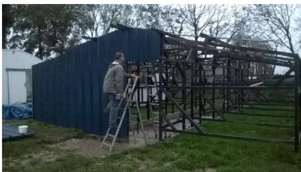
Petite petite volière (construction)
