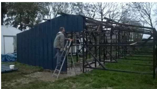
Petite petite volière (construction)
